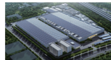
光伏发电项目
